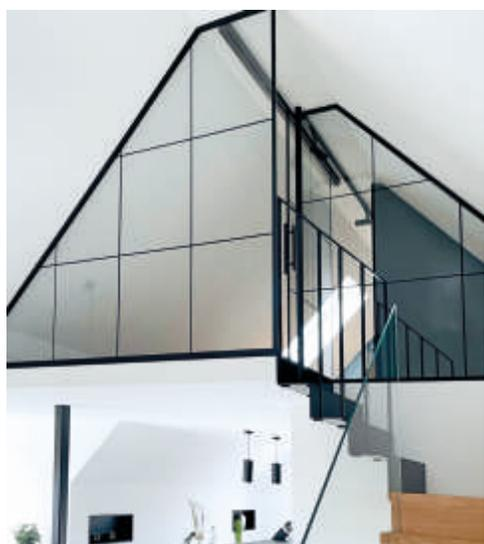
Dabei verwenden wir Sicherheitsgläser bei denen die schwarzen Sprossen mittels eines speziellen Verfahrens einseitig auf das Glas aufgedruckt sind.
